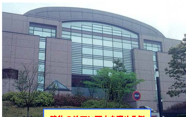
建物の地下に雨水を溜める例
