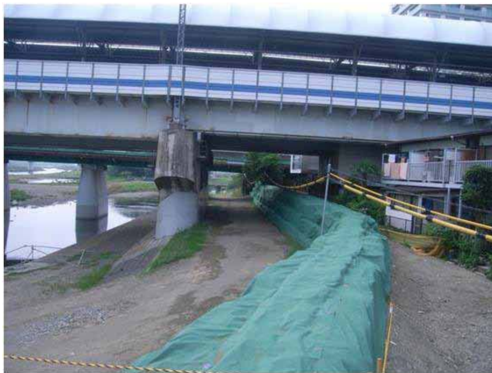
＜暫定整備した計画高水位までの仮整備の土のう＞
