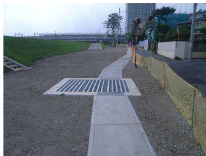
＜排水樋管に接続された排水路＞
