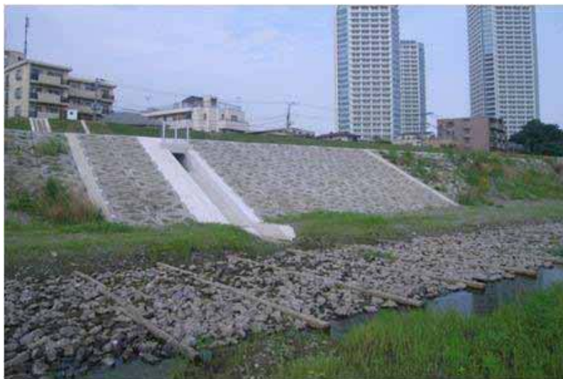
＜完成した排水樋管＞
