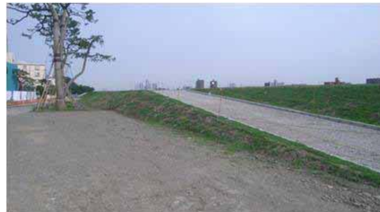
〈住宅側のスロープ〉
