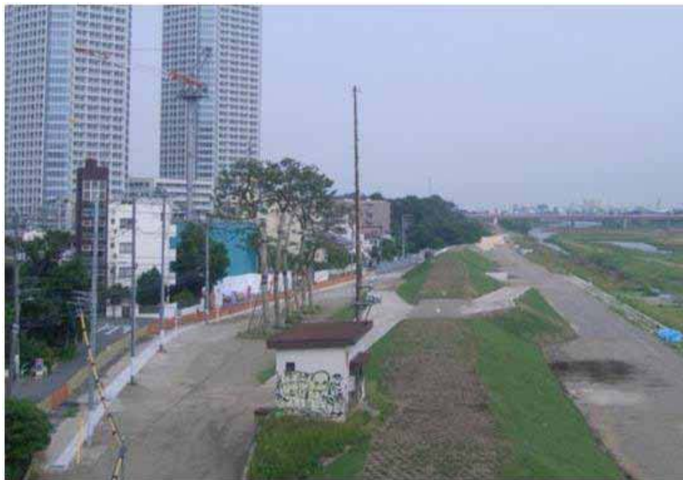
〈整備された住宅側と多摩川側のスロープ〉
