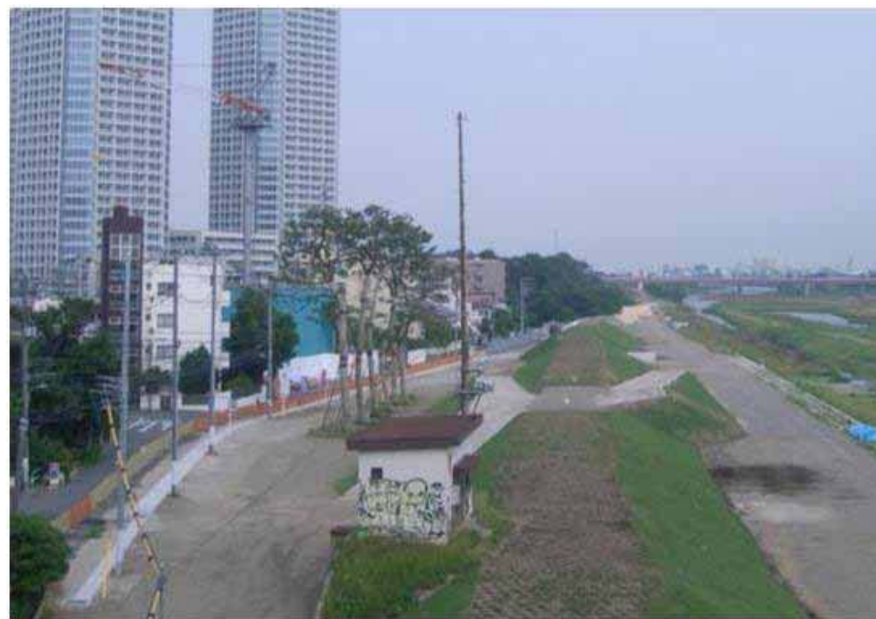
公共空地に設置された バリアフリーのスロープ
