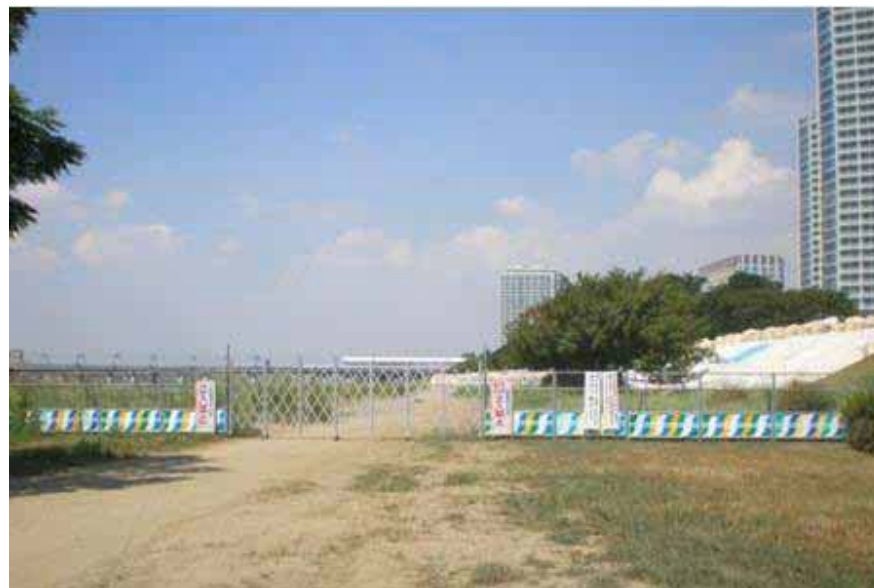
<河川敷における立ち入り制限柵(下流部)>
