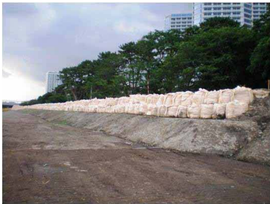
<下流区間(土のうによる仮整備：堤防整備中)>
