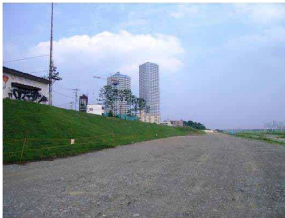
<上流区間(整備完了)>
