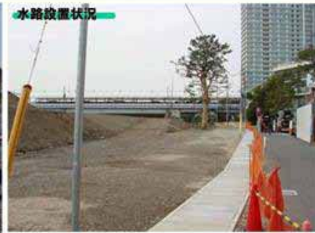
水路設置状況
