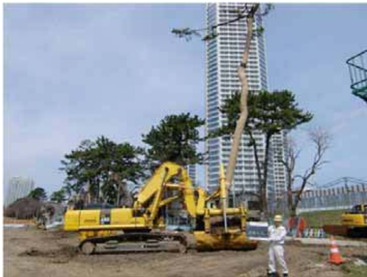
＜TPM工法による移植状況＞
