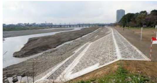
工事完成写真(平成21年3月末撮影)
