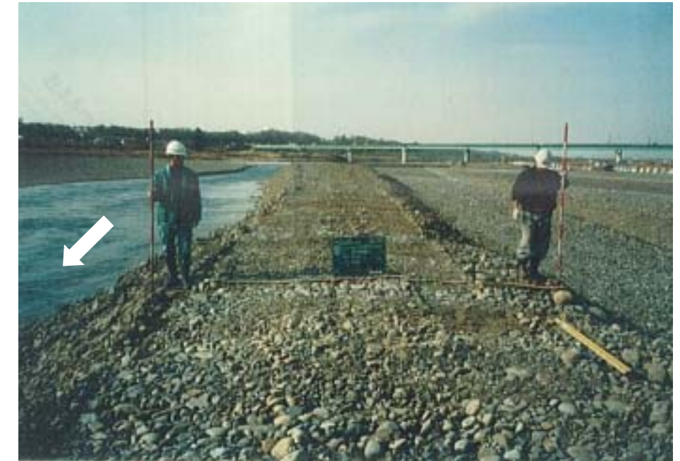
H14年度施工時点
