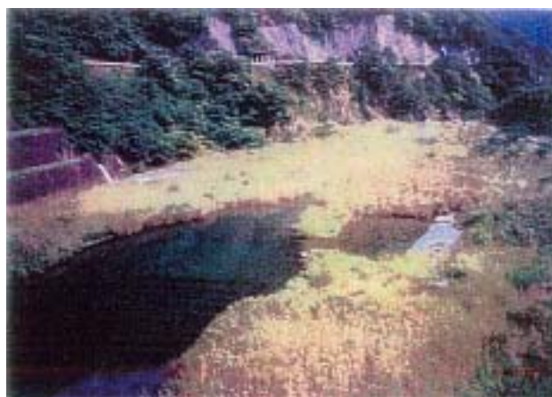
H12.9 土砂供給前 河床が低下し、護床工ブロックが見えている
