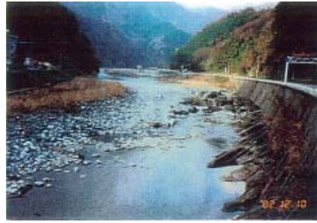
H14 流水部の砂利が流れ去り、露岩が著 しい。河床は2~3m 低下している
