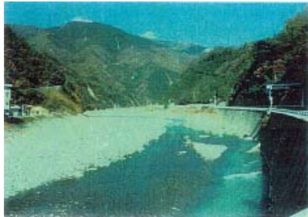
S54 ダム竣工直後 流水部に中州が現れるほど砂利 が豊富に存在した
