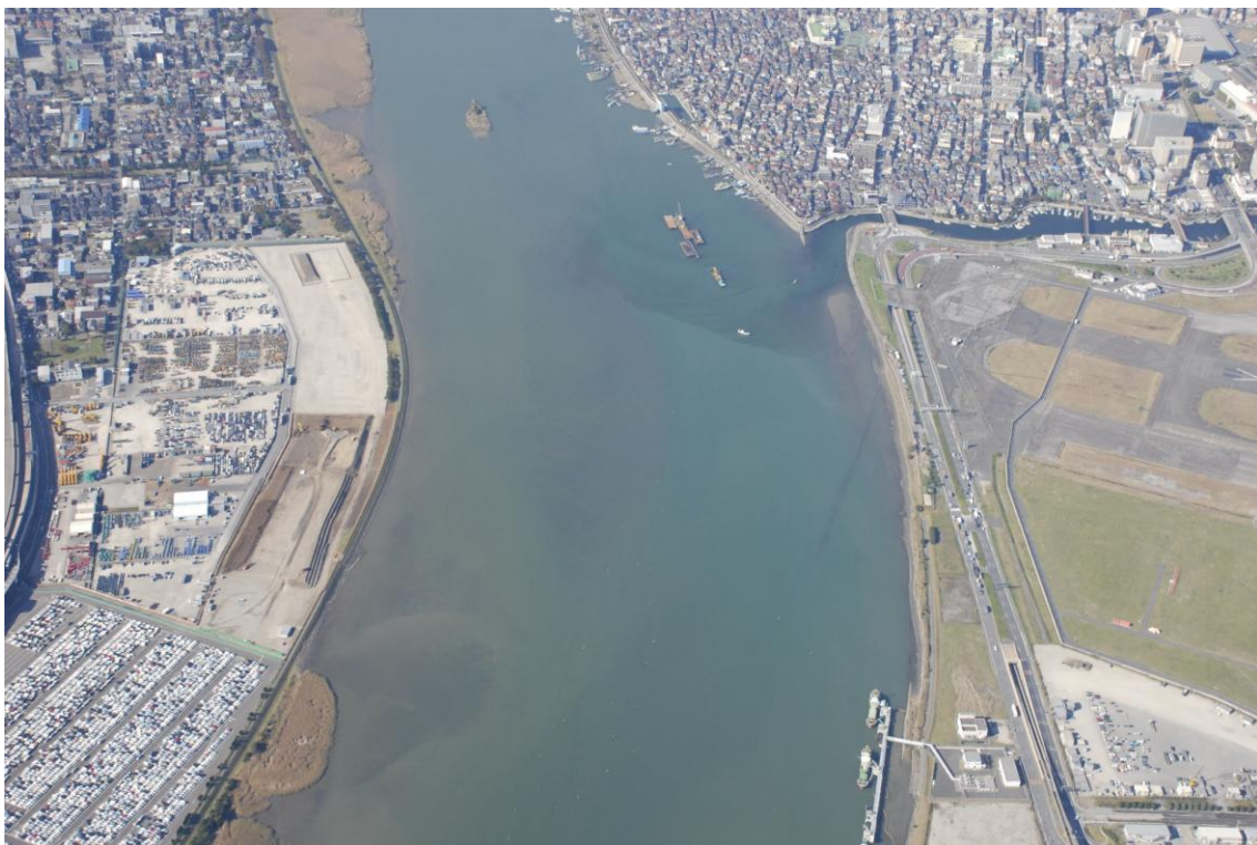
河口から 1km 付近
