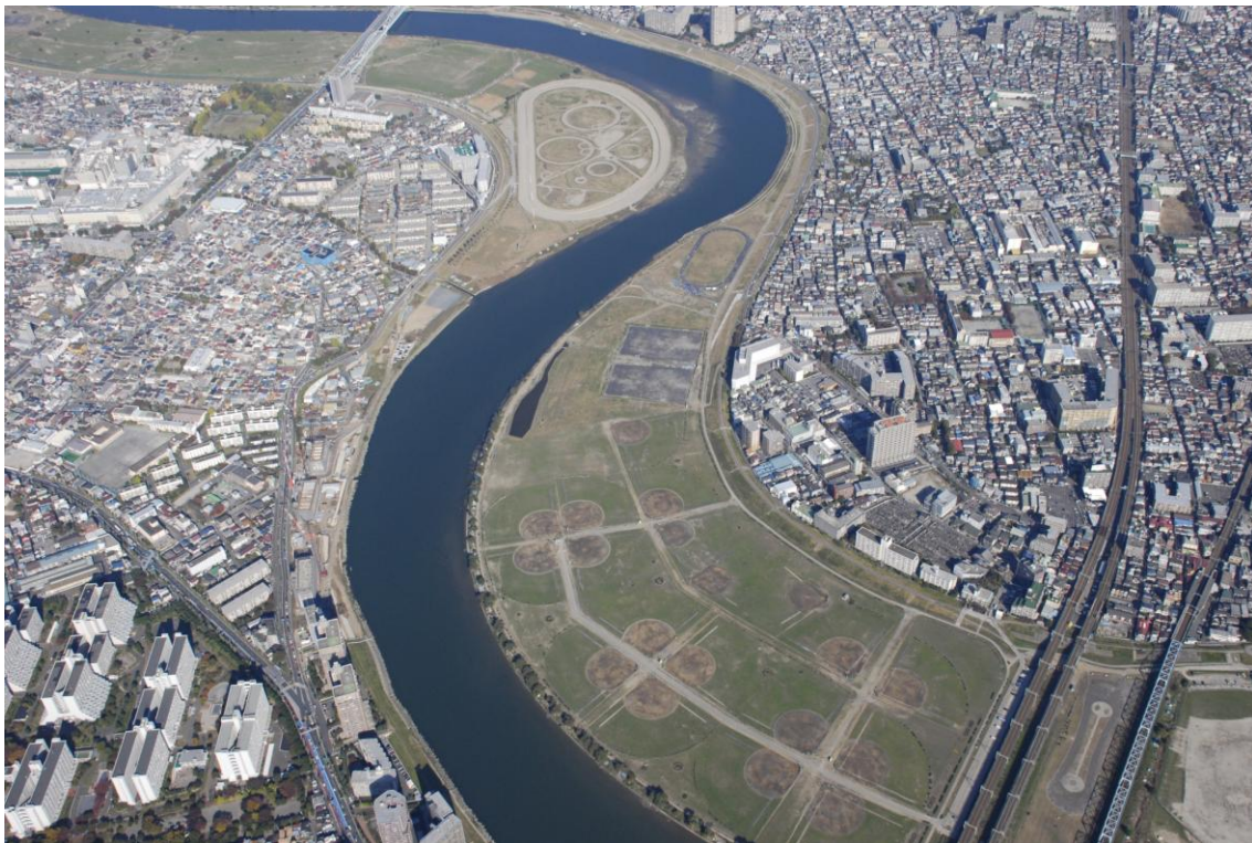
河口から 7km 付近
