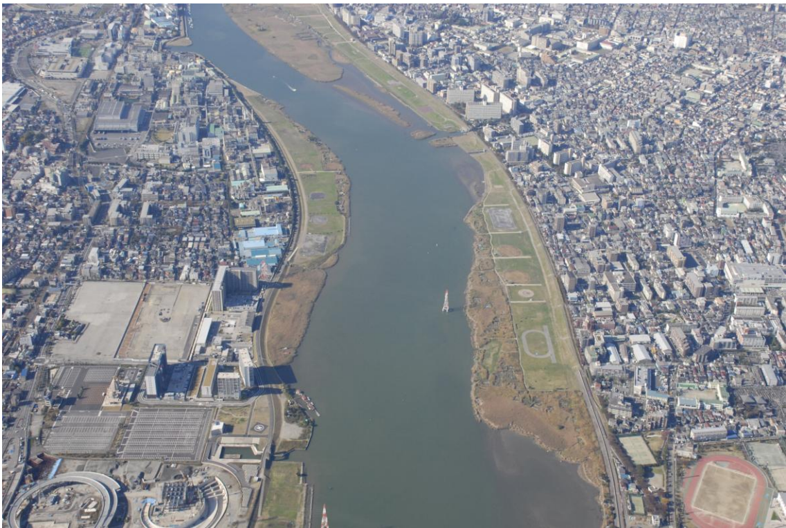
河口から 3km 付近
