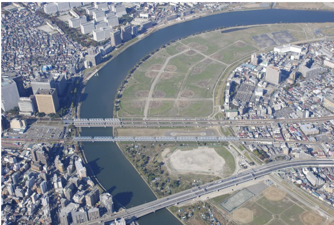
河口から 6km 付近
