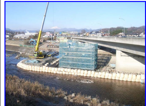
写真② 橋梁区間の施工状況
