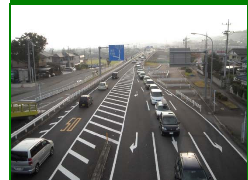
写真② 久芳橋付近 (2/4車線供用区間)
