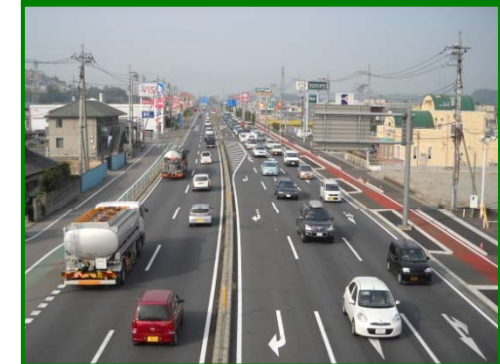
写真① 岩井交差点付近 (4/4車線供用区間)
