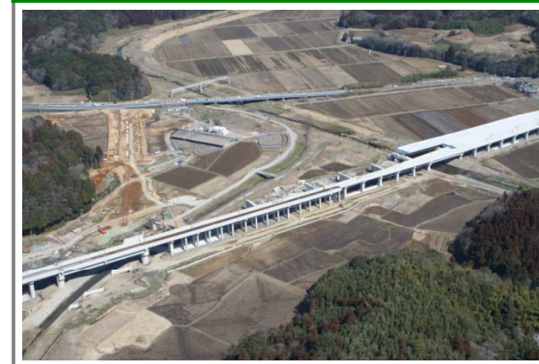
松崎高架橋付近(空撮)
