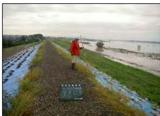
利根川の仮復旧箇所で亀裂等が発生していないか巡視中
