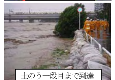
土のう設置状況
