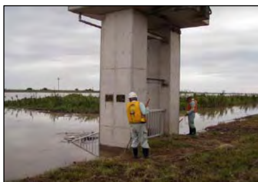
利根川の河川構造物に異常が生じていないか巡視中
