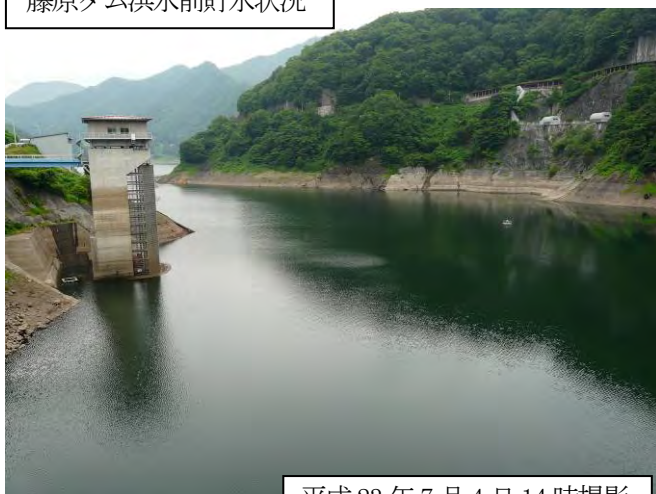
藤原ダム洪水前貯水状況
