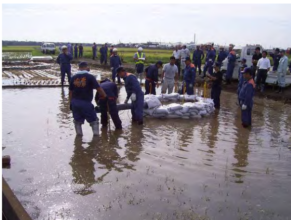
水防工法：釜段工法（利根川）H19.9
