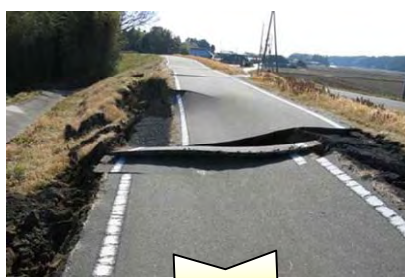
34 茨城県那珂市鹿島地先 久慈川（右岸17.5k～18.6k）
