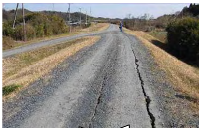
37 茨城県常陸大宮市富岡地先 久慈川(左岸24.0k~25.0k)
