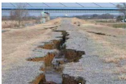
23 茨城県水戸市下大野地先 那珂川（右岸3.8k～4.5k）
