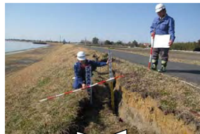
43 茨城県神栖市高浜地先 常陸利根川 常陸川（左岸8.0k～8.1k）
