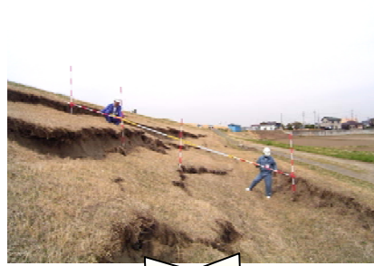
12 茨城県北相馬郡利根町布川地先 利根川下流(左岸74.1k~75.0k)
