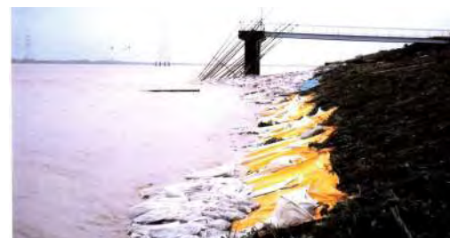
河川水の堤防への侵入を防ぐ（シート張り工）
