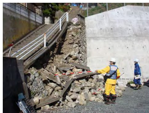
TEC-FORCE による急傾斜地調査（茨城県）
