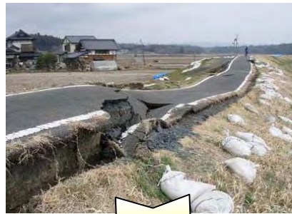
38 茨城県常陸太田市藤田町地先 久慈川 山田川(左岸3.5k~3.7k)
