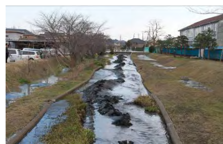
川底が液状化により隆起した十間川
