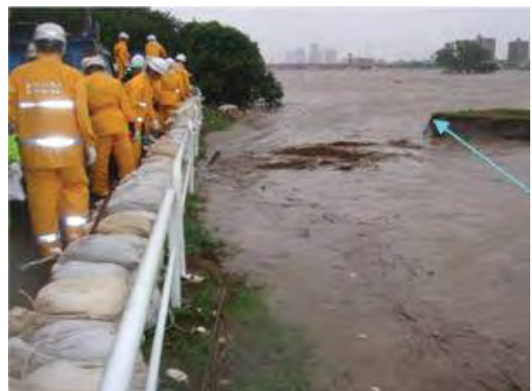
水防工法：土のう積み（多摩川）H19.9
