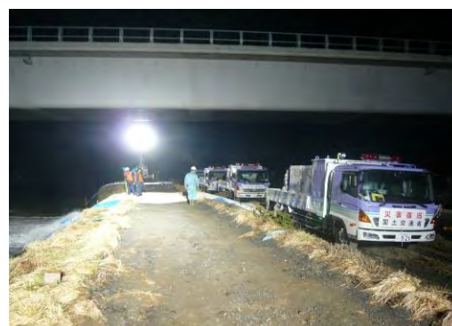
TEC-FORCE による排水ポンプ車支援 （宮城県巨野町）
