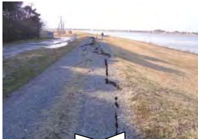
42 茨城県神栖市日川地先 常陸利根川 常陸川（右岸2.5k～5.0k）
