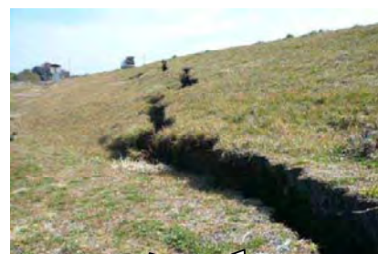
25 茨城県水戸市東大野地先 那珂川（右岸7.2k～7.3k）
