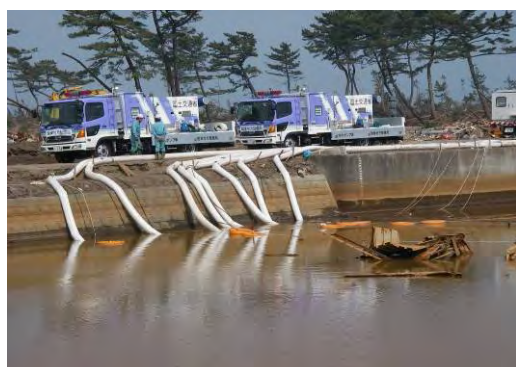
TEC-FORCE による排水ポンプ車支援 （宮城県仙台市）
