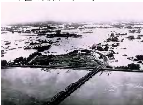
写真 2-2-1 埼玉県久喜市（旧栗橋町）利根川
