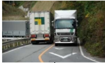
国道141号南牧村市場坂 (急カーブ 急勾配)
