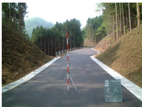
< 工事完成直後 >
