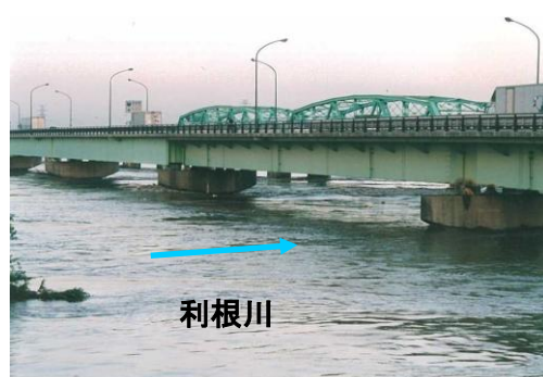
写真 2-2-16 埼玉県久喜市（旧栗橋町） （利根川）
