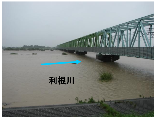
写真 2-2-17 埼玉県久喜市（旧栗橋町）（利根川）
