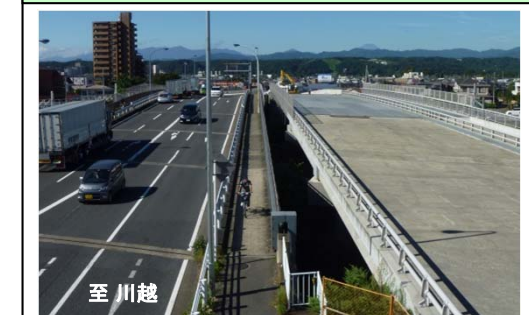
② 国道16号 武蔵野橋
