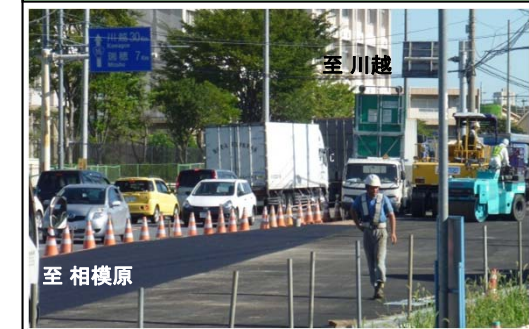
① 国道16号 松原地区
