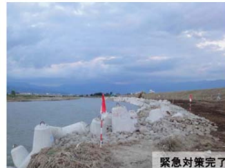
緊急対策完了
