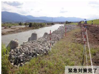
緊急対策完了
