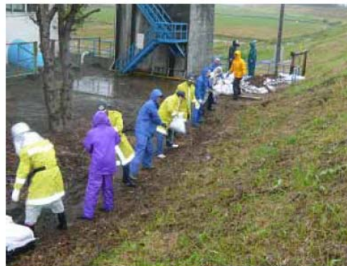
小貝川 右岸49.5k 上野2号排水樋管付近（筑西市） 水防団 月の輪工法による漏水対策（22日17:30頃）
