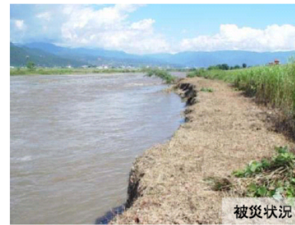
左岸側（対策延長：約210m）
