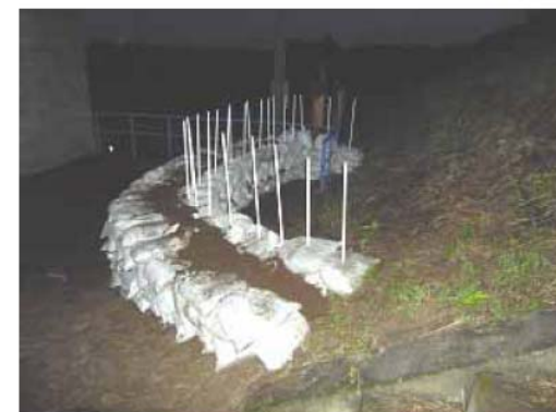
小貝川 右岸49.5k 上野2号排水樋管付近（筑西市） 水防団 月の輪工法による漏水対策（22日17:30頃）
