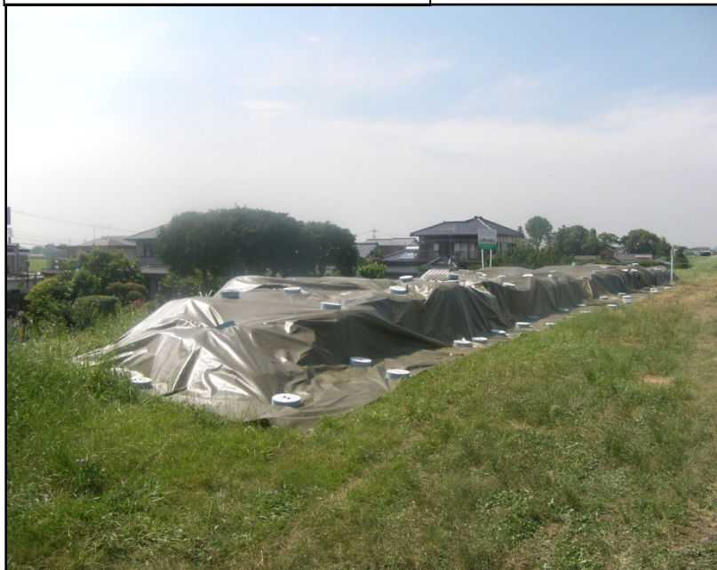
小貝川右岸30.2k付近
