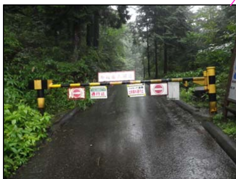
通行止め状況 (稲荷川第10砂防堰堤側)
