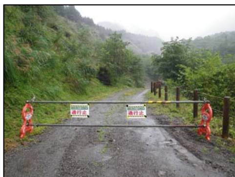
通行止め状況 (崩落箇所 下流側)
