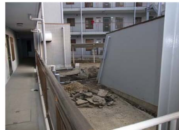
写真 33 液状化により沈下した集合住宅の施設（川原代町地区）
