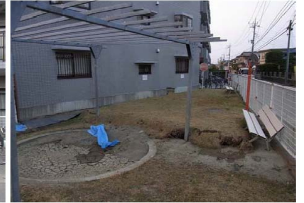
写真 32 液状化により周辺地盤が沈下した集合住宅（川原代町地区）
