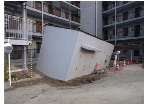
写真 32 液状化により周辺地盤が沈下した集合住宅（川原代町地区）
