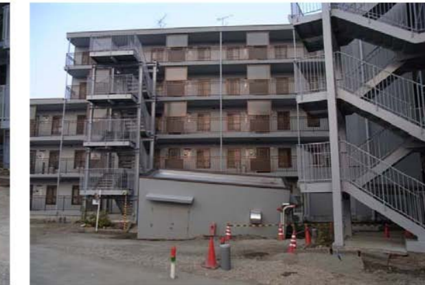
写真 32 液状化により周辺地盤が沈下した集合住宅（川原代町地区）
