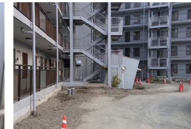
写真 33 液状化により沈下した集合住宅の施設（川原代町地区）
