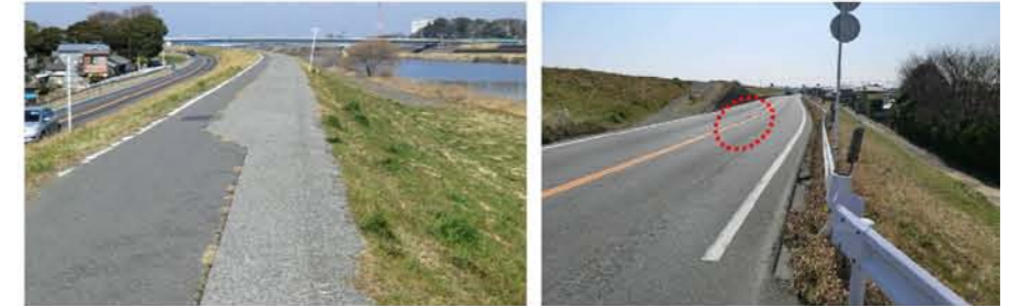
川表側は被害なし 川裏側は路面に縦断亀裂 +これに並行した亀裂+噴砂 +のり尻部の沈下・段差
