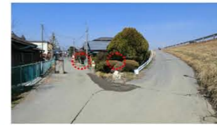
利根川堤防に隣接した家屋の状況1
