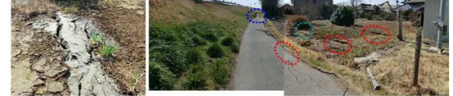
川表側は被害なし 川裏側は路面に縦断亀裂 +これに並行した亀裂+噴砂 +のり尻部の沈下・段差
