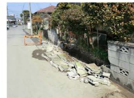
地震中から数箇所所で砂混じりの水が高さ50cm程度まで噴出し、約30分間継続したとのこと (他の家屋では約10分間という事例もあり) その後の余震での噴出はなかったとのこと 昭和30年代に引っ越してきてから初めての経験(1987年千葉県東方沖地震では液状化せず)
