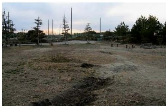
旭市吉崎浜：野外活動施設でみられる亀裂と噴砂。標高の低いところでは噴砂がみられる。
