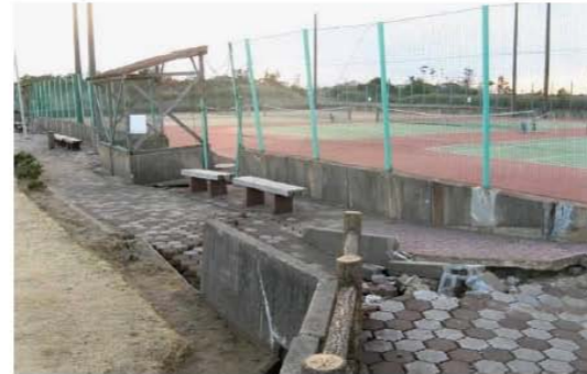
旭市吉崎浜：野外活動施設内のテニスコート施設の変形・亀裂を示す。
