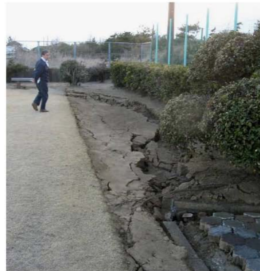
旭市吉崎浜：野外活動施設内のテニスコート施設の亀裂を示す。
