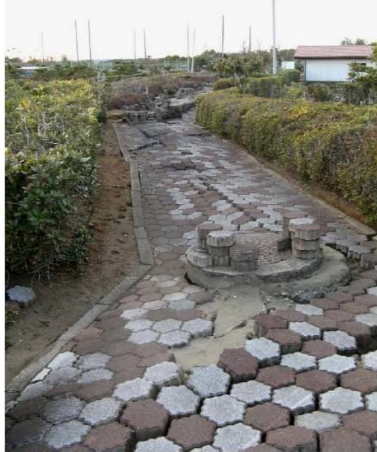
旭市吉崎浜：野外活動施設でみられる斜面沿いの沈下を示す。
