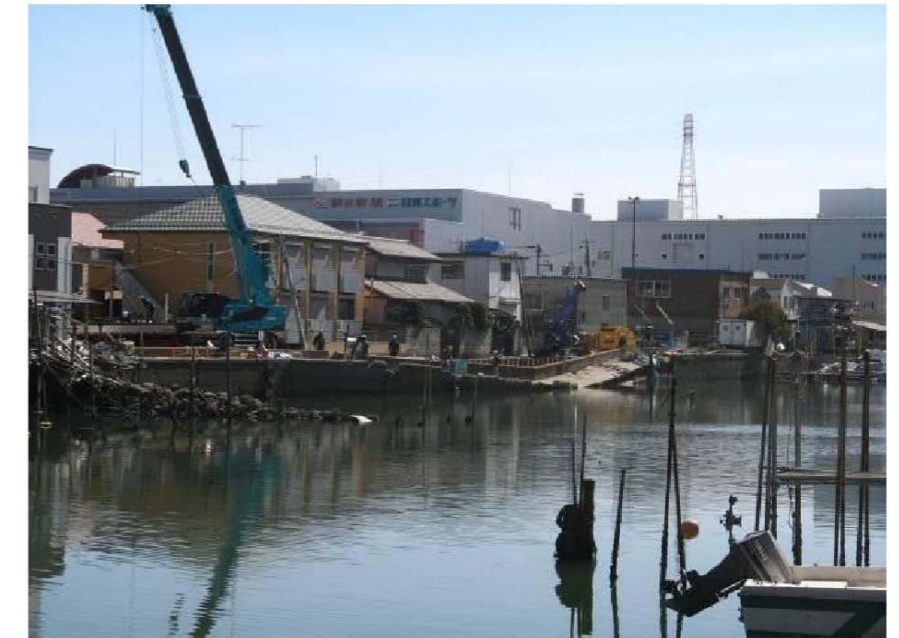
日の出2丁目：西側護岸の一部が崩れた。
