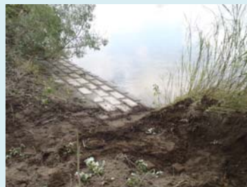
【護岸の確認】 (春日部市東中野地先)
