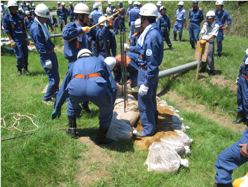
堤防法面からの漏水を想定した月の輪工
