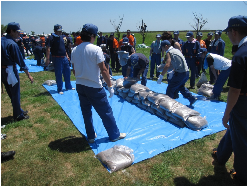
堤防天端の波浪・越水を想定した積み土のう工
