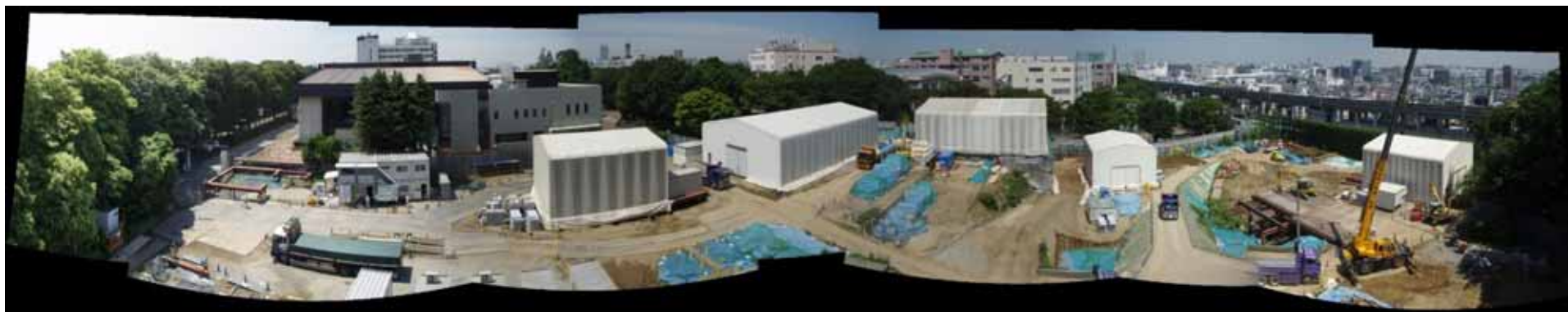
土壌汚染除去の状況
