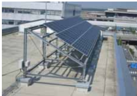
太陽光発電設備の例
