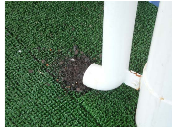
補修を繰り返している支柱部
