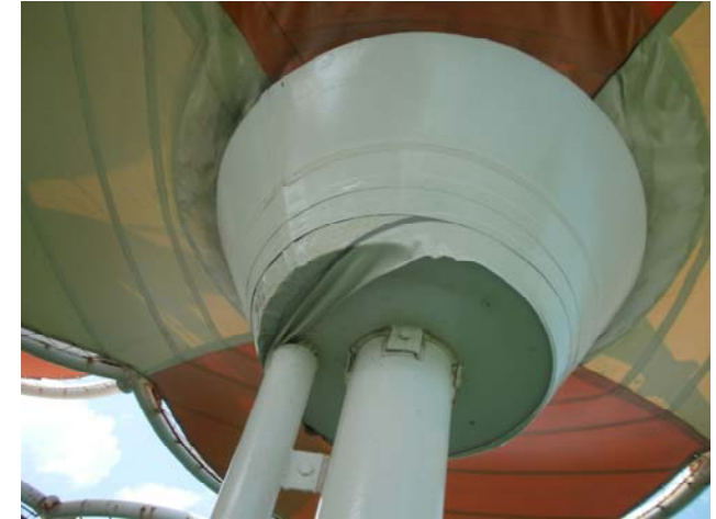
補修を繰り返している支柱部
