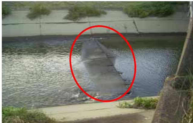
【段差】不同沈下による底版浮き上がり状況 (No.132+50m三枚橋下)
