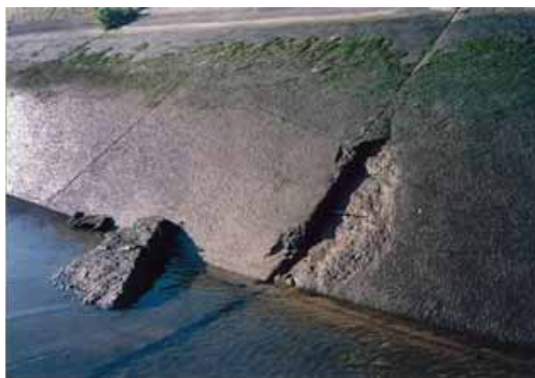
欠損の状況 (No2+70右岸側)
