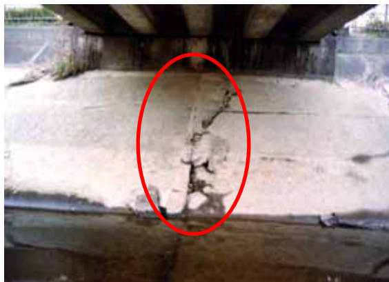
【欠損・クラック】ライニングパネル損傷状況 (No.88+85m並木橋左岸下)
