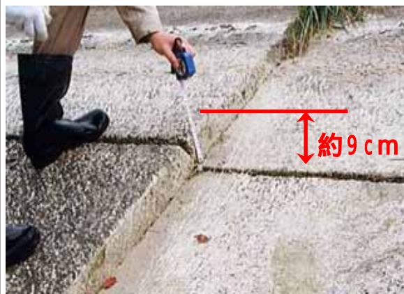
段差の状況 (No132付近左岸側)
