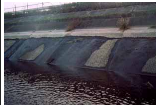
漏水の状況 (No98付近右岸側)
