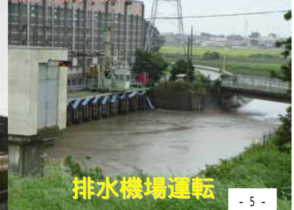
糠田排水機場
