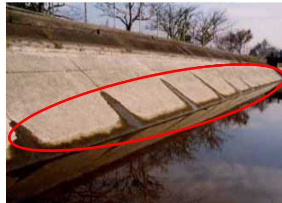
【漏水・湧水】ライニングパネル継目漏水状況 (No.25+00m付近左岸側)
