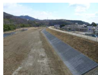
【対策工実施状況】
