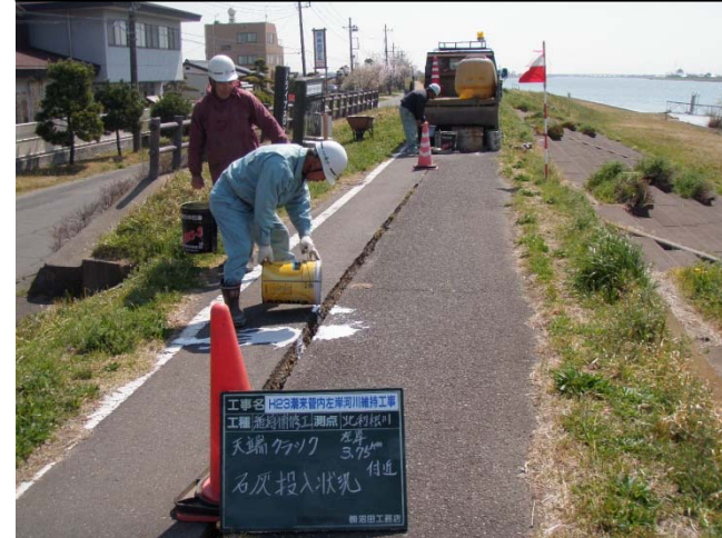
③舗装及び砂散布状況
