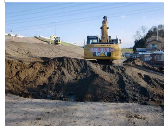
②掘削状況
