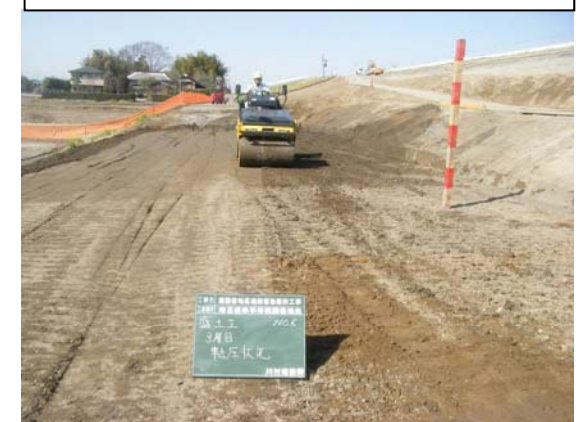
④転圧状況
