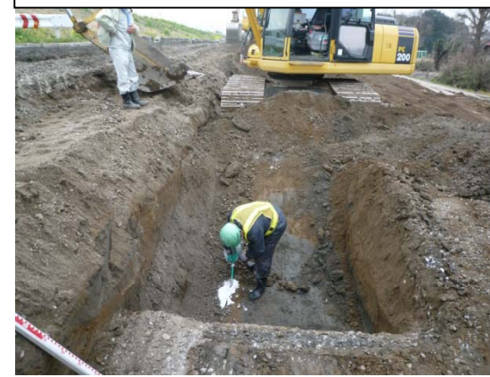
①クラック石灰水注入状況
