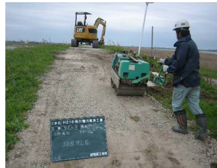
《復旧完了状況》
