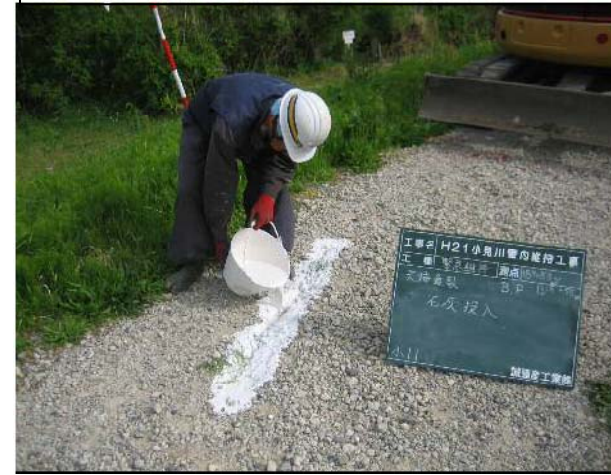
①クラック石灰水注入状況
