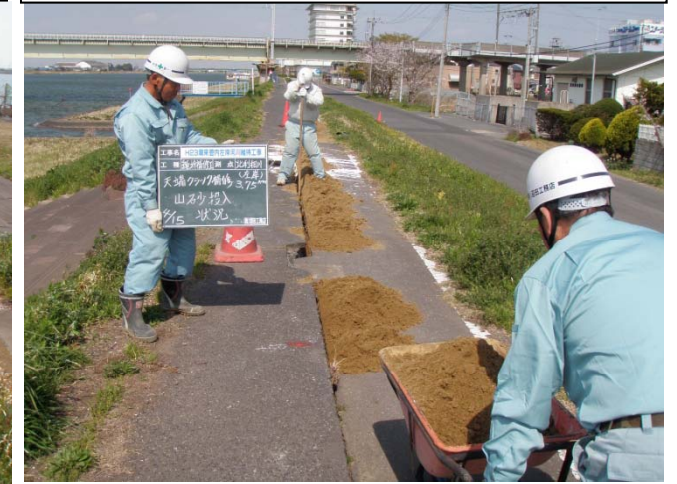
②砂充填状況
