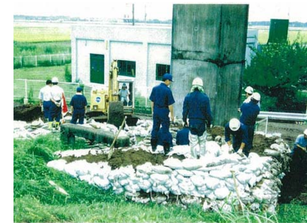
漏水対策のための水防実施事例
