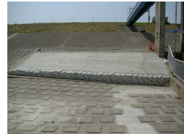
応急復旧状況(神崎樋管)
