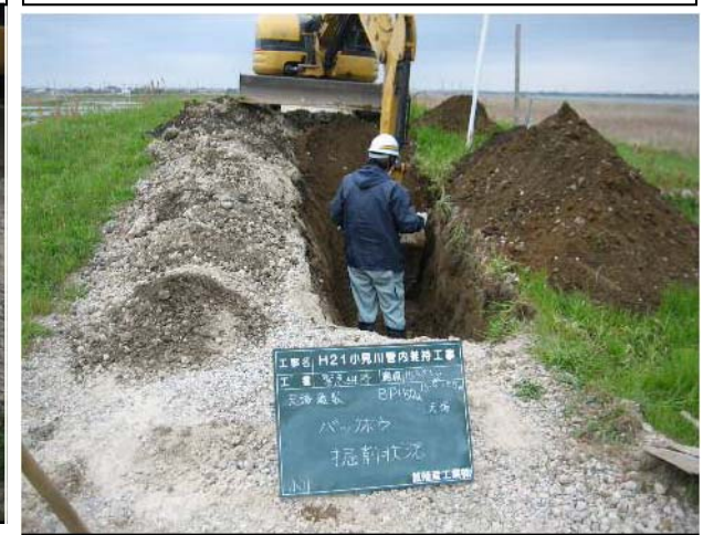
②掘削状況
