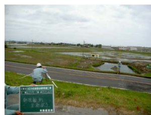
測量による沈下計測(飯島樋管)
