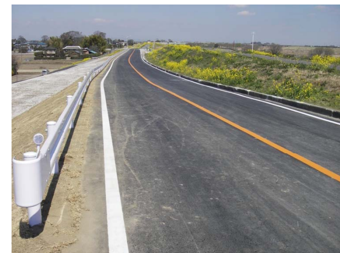
《出水期前対応状況》
