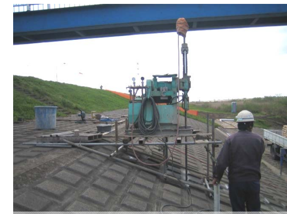
グラウト実施状況(神崎樋管)
