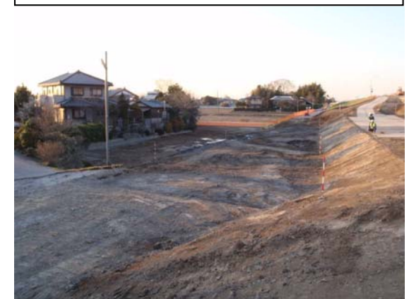
③掘削完了
