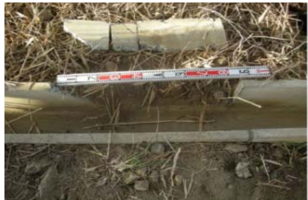
側溝損傷状況
