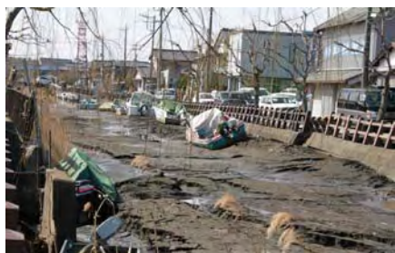
川底が液状化により隆起した小野川
