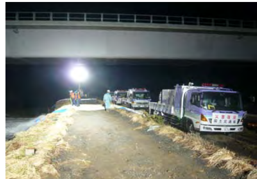
TEC-FORCE による排水ポンプ車支援 （宮城県亘理町）
