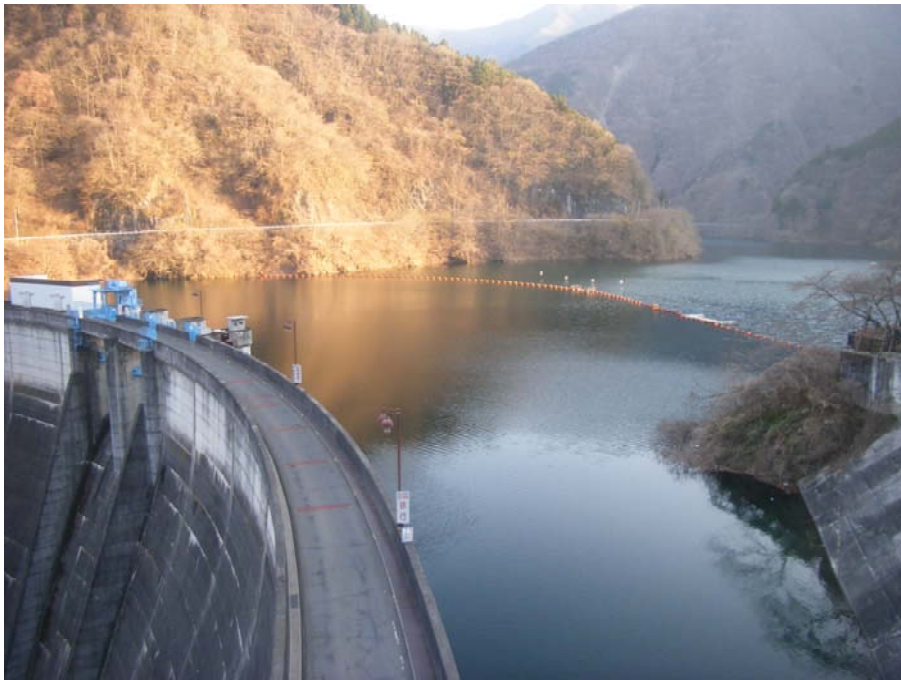
二瀬ダム(平成23年4月13日撮影)
