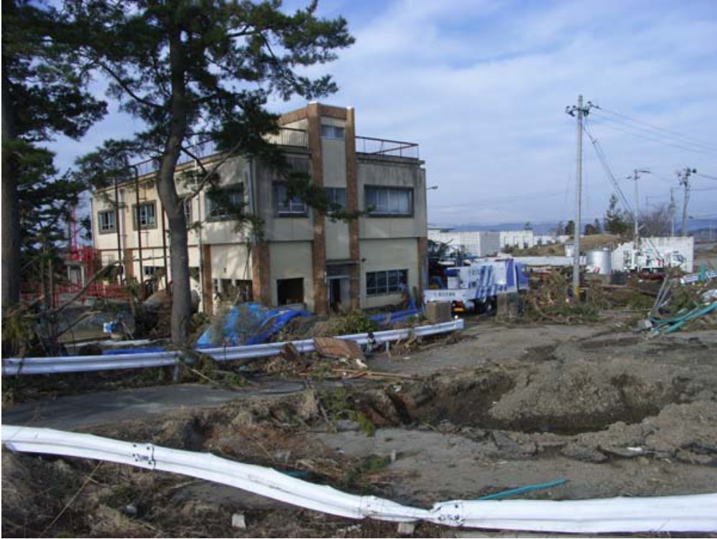
津波により土砂や瓦礫が襲った排水機場周辺での排水作業状況
