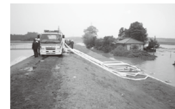
平成16年久慈川水系玉川での排水ポンプ車作業状況
