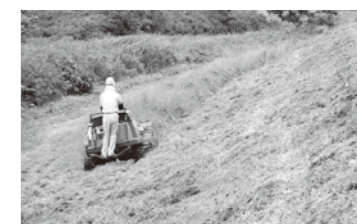
堤防の異常(亀裂、陥没等)の早期発見や強度維持のため、堤防除草を行います
