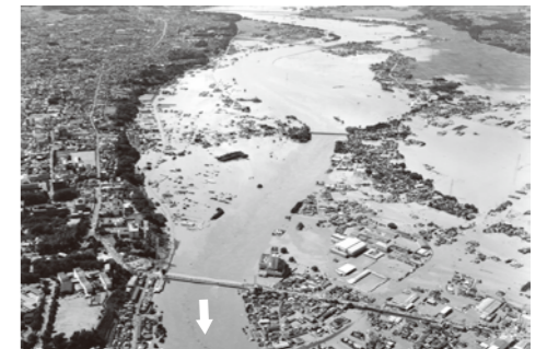
昭和61年8月の那珂川水府橋付近
