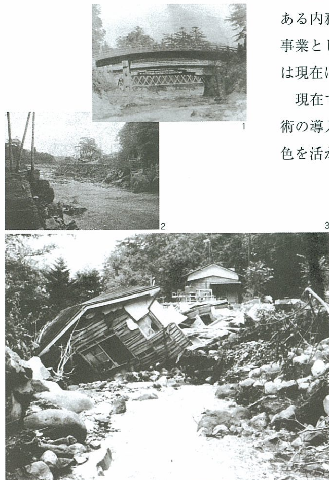
1,2 明治35年9月、足尾台風による被害（神橋付近）の被害前(1)と被害後(2) 3 昭和41年9月、台風26号による被害（日光市山内）
