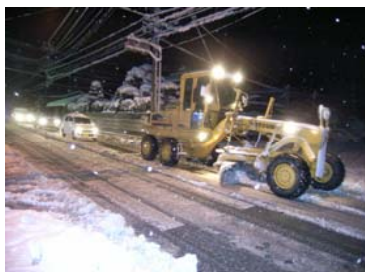
グレーダーによる除雪
