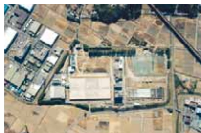
空から見た元荒川水循環センター
