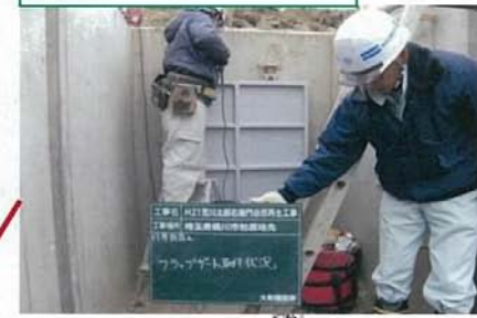
フラップゲート設置状況
