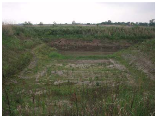
5/22 施工区(特に2段目)に草本が繁茂
