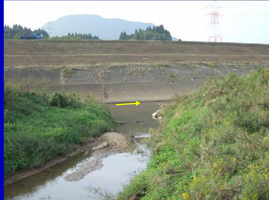
本川からの流入部 本川水位の上昇に合わせて、 水が流入して来る
