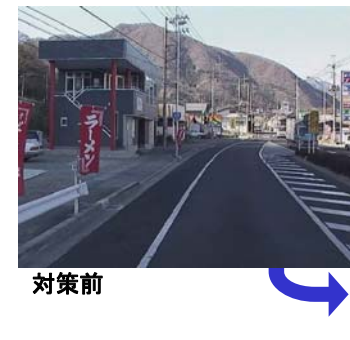
路面標示(中央ゼブラ拡幅)本線・路肩のシフト
