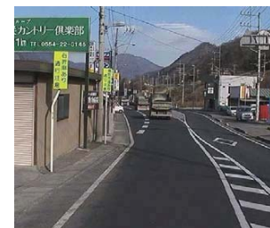
写真 対策実施後の状況
