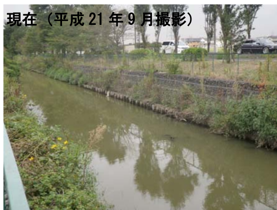
図 3.3.1 末田落しの多自然護岸（かごマット）
