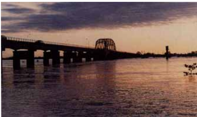
【昭和57年9月】 台風18号 (さいたま市) 治水橋
